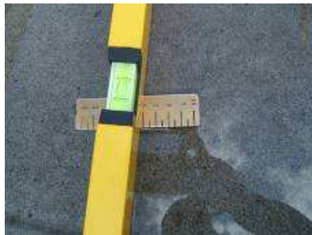
Obr.19-22 Terasa v 6NP, 4.09 T - není ve spádu k odpadu, viditelná prohlubeň v místě stojící vody. Nevhodný detail u vstupu na terasu.
