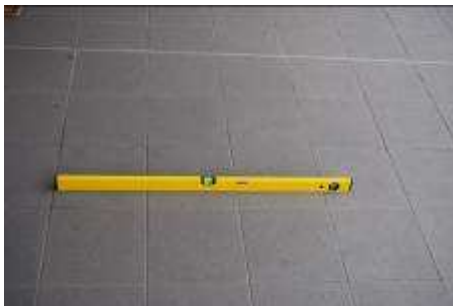
Obr. 9,10 Kontrola sklonu dlažby.
