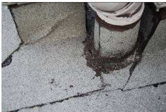
Obr. 35-37 Prostupy skrz střešní rovinu.
