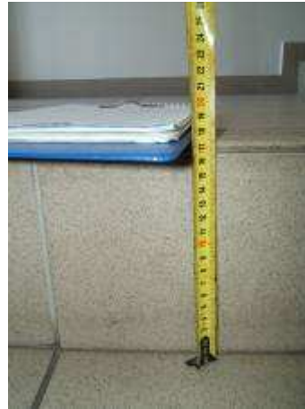
Obr. 53-55 Rozdílná výška jednotlivých stupňů na jednom rameni.
