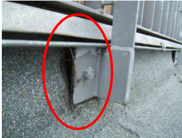
Obr. 38 Střecha nad částí s pavlačemi (Sekce 5).
