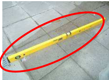
Obr.19-22 Terasa v 6NP, 4.09 T - není ve spádu k odpadu, viditelná prohlubeň v místě stojící vody. Nevhodný detail u vstupu na terasu.
