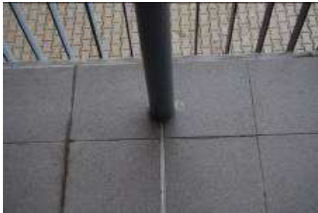
Obr. 7, 8 Detail utěsnění kolem sloupů.
