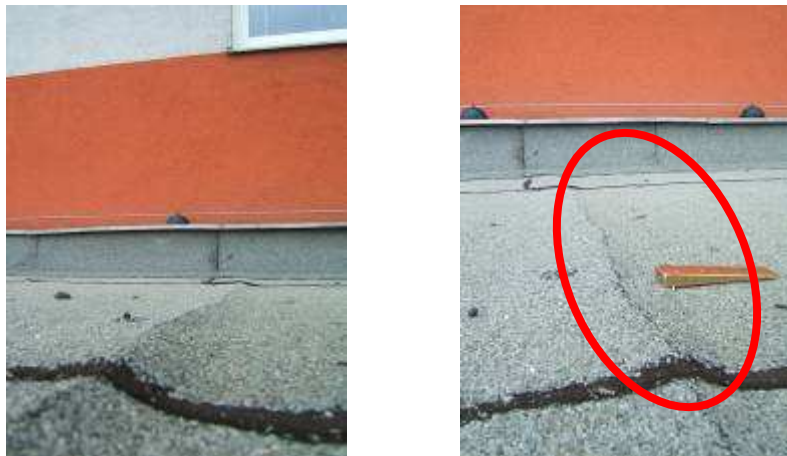
Obr. 33, 34 Střecha nad částí s pavlačemi (Sekce 5).
