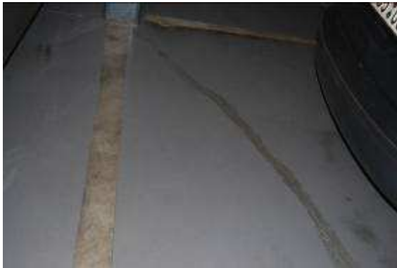
Obr. 59-61 Praskliny v betonové podlahové desce.
