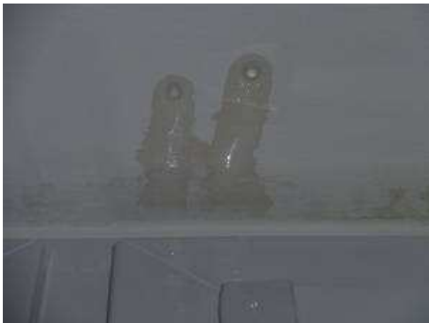
Obr. 23, 24 Zatékání v místě nadpraží okna v bytové jednotce pod terasou.
