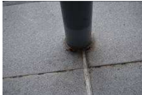
Obr. 7, 8 Detail utěsnění kolem sloupů.
