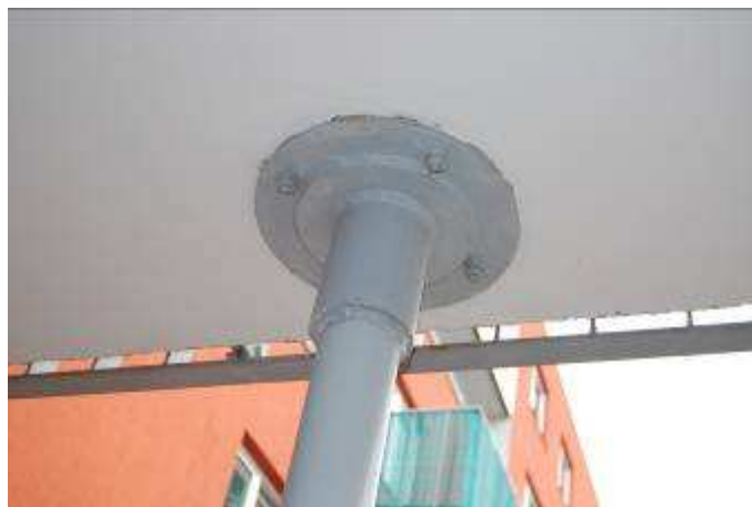
Obr. 4, 5, 6 Zhlaví sloupů na pavlačích v 2NP.
