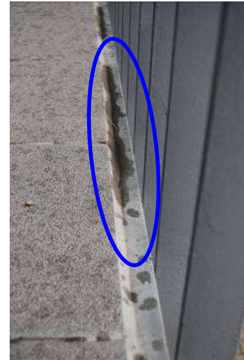
Obr. 11 Detail ukončení dlažby u okapové lišty.
