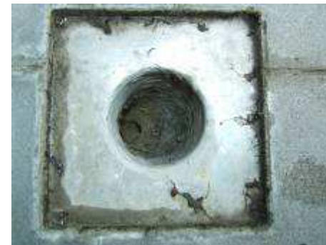
Obr.19-22 Terasa v 6NP, 4.09 T - není ve spádu k odpadu, viditelná prohlubeň v místě stojící vody. Nevhodný detail u vstupu na terasu.
