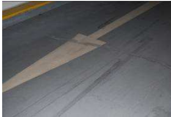
Obr. 59-61 Praskliny v betonové podlahové desce.
