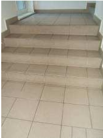
Obr. 53-55 Rozdílná výška jednotlivých stupňů na jednom rameni.
