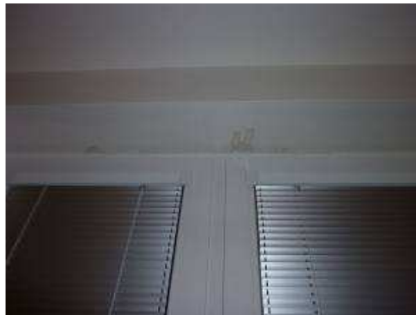
Obr. 23, 24 Zatékání v místě nadpraží okna v bytové jednotce pod terasou.
