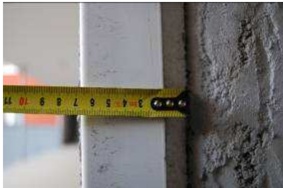
Obr. 69-71 Tloušťka tepelné izolace na obvodové stěně..
