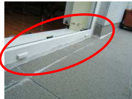
Obr.19-22 Terasa v 6NP, 4.09 T - není ve spádu k odpadu, viditelná prohlubeň v místě stojící vody. Nevhodný detail u vstupu na terasu.
