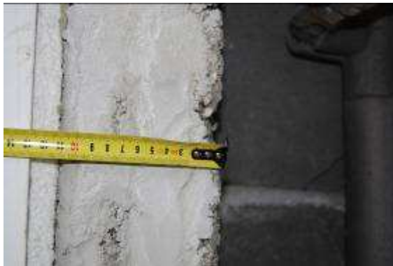
Obr. 69-71 Tloušťka tepelné izolace na obvodové stěně..
